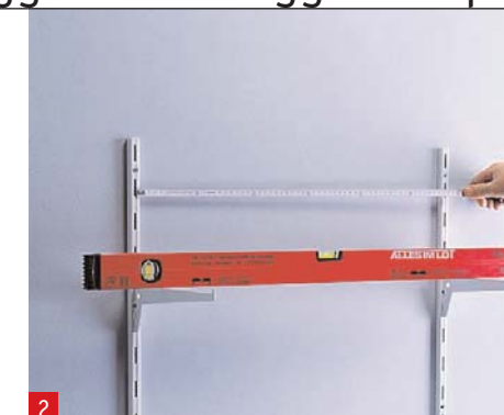
2 Con l'aiuto dei sostegni disporre le ulteriori sbarre nella giusta posizione e fissarle
