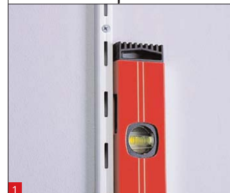
1 Posizionare la prima sbarra e montarla al muro con tasselli e viti
