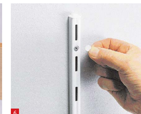
6 Cacher les têtes des vis avec des capuchons à vis
