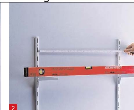
2 Positionner le montant suivant à l'aide des consoles, puis le fixer
