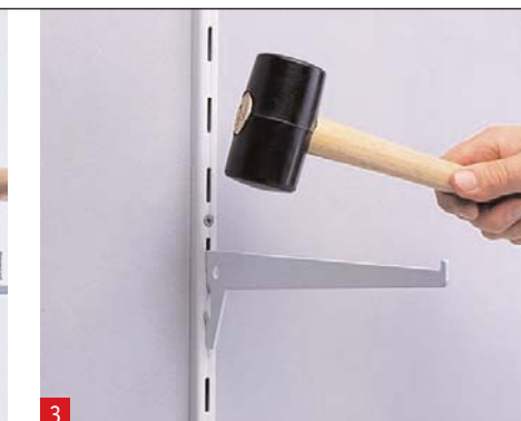
3 Placer et enficher les consoles
