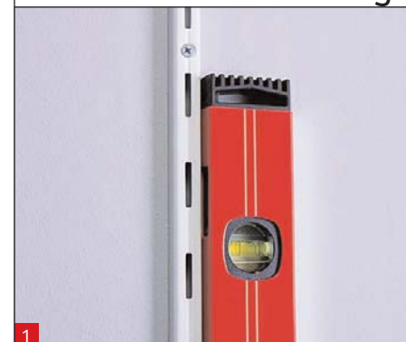
1 Ajuster le premier montant et le fixer à la paroi au moyen de tampons et de vis
