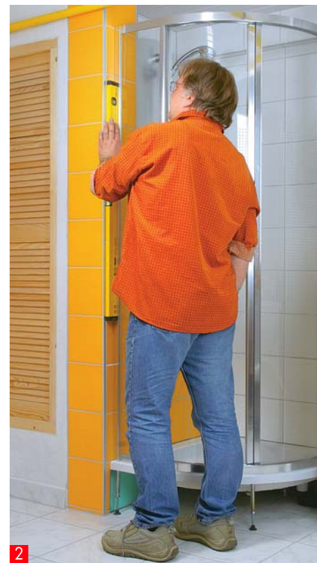
2 Poggiate ora la parete doccia assemblata sulla vasca e allineatela come desiderate.
