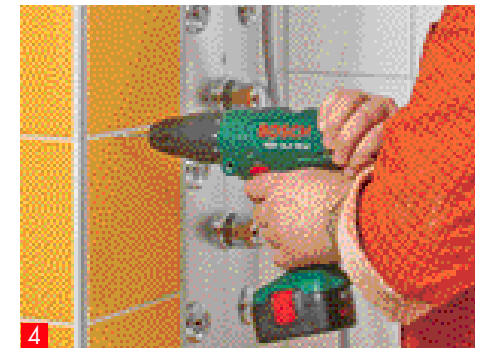
4 ... die Position der Duschtrennung sowie die Bohrpunkte zur Montage der Wandanschlussprofile. Stellen Sie die Abtrennung wieder ...
