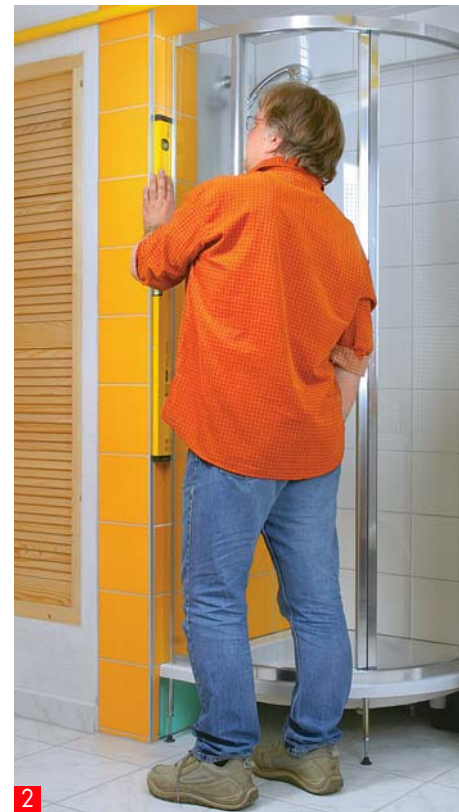
3 Messen Sie den Abstand von der Aussenseite der Abtrennung bis zur Aussenseite der Duschwanne gemäss Anleitung ab. Markieren Sie dann ...
