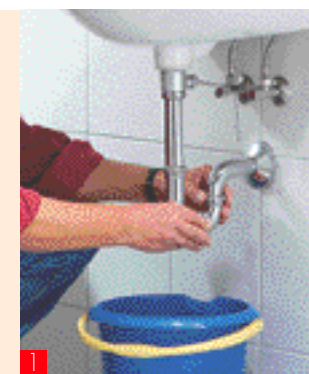
1 Lösen Sie die beiden Verschraubungen am unteren Rohrbogen
