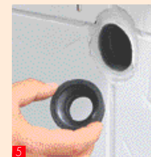
5 Den Gummistopfen am Wandanschluss am besten erneuern
