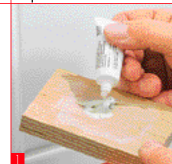
1 Reinigen Sie die Stelle, dann drücken Sie Spachtelmasse auf ein Brettchen und verrühren es mit dem Härter
