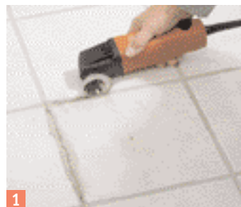
1 Con il MultiMaster di precisione incidere le fughe tutt'intorno,...
