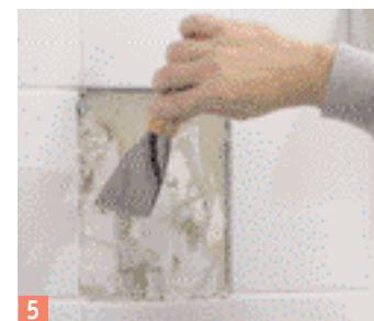
5 ... affinché il mastice per riparazioni utilizzato, abbia una migliore tenuta.
