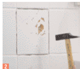
2 Colpire poi con il martello la piastrella danneggiata ...
