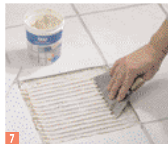
7 Mettere l'adesivo per piastrelle sul fondo, ...
