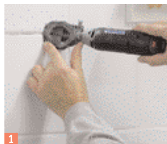
1 Il Dremel è adatto anche per togliere le fughe tutt'intorno.
