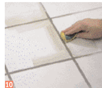
10 ... penetrare la malta nelle fughe. Pulire con una spugna.
