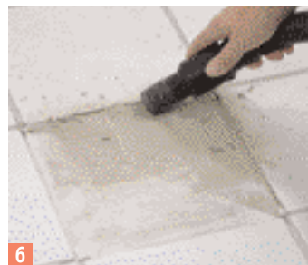
6 Togliere i resti di malta e di piastrella con un aspirapolvere.
