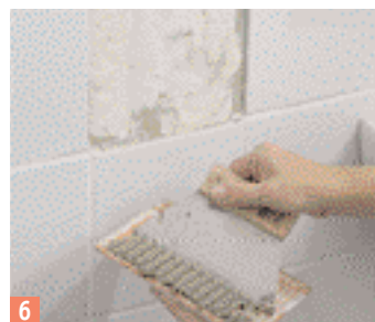
6 Quando il mastice è asciutto, stendere l'adesivo per piastrelle sul...
