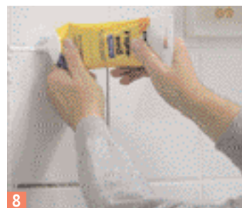
8 Se le fughe sono piccole, si presta bene il mastice per giunzioni, già ...
