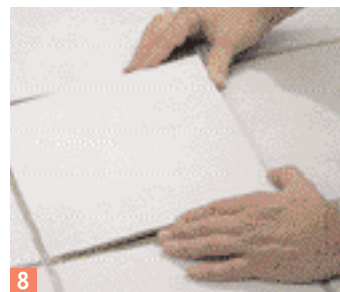
8 ... stenderlo con una spatola dentata e posare ...
