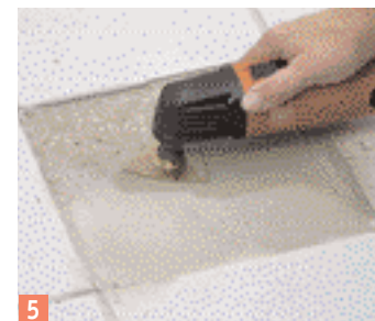
5 ... montare la raspa per il metallo duro, poi levigare il fondo.
