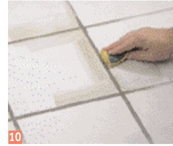
5 ... montieren die Hartmetallraspel und glätten den Untergrund
