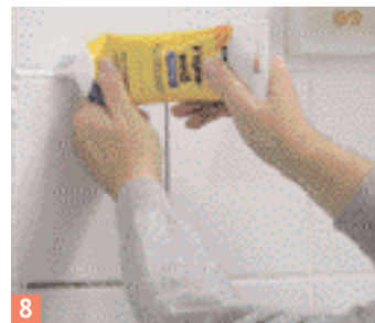
8 Müssen Sie nur wenig verfugen, bietet sich Fertigfugenmasse an
