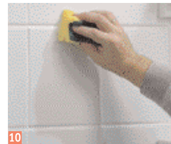
10 Überschüssiges Material entfernen Sie mit einem Schwamm
