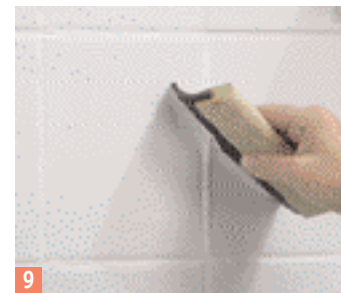
9 Auch diese verteilen Sie sorgfältig mit einem Gummiwischer
