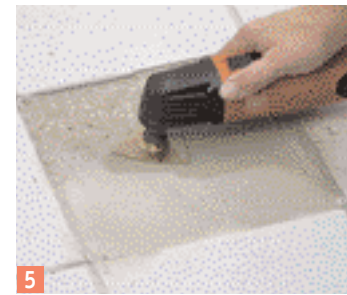
5 ... montieren die Hartmetallraspel und glätten den Untergrund
