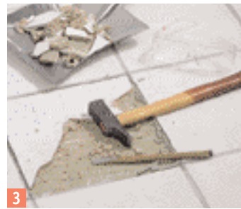
3 ... bilden. Dann schlagen Sie die Fliese mit Hilfe eines Meissels ...
