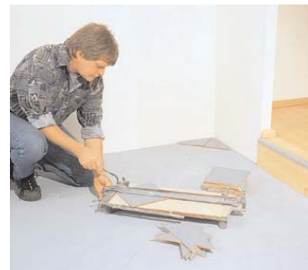
1 Markieren Sie die Diagonale des Raumes von einer Ecke zur anderen und schneiden die Fliesen ...
