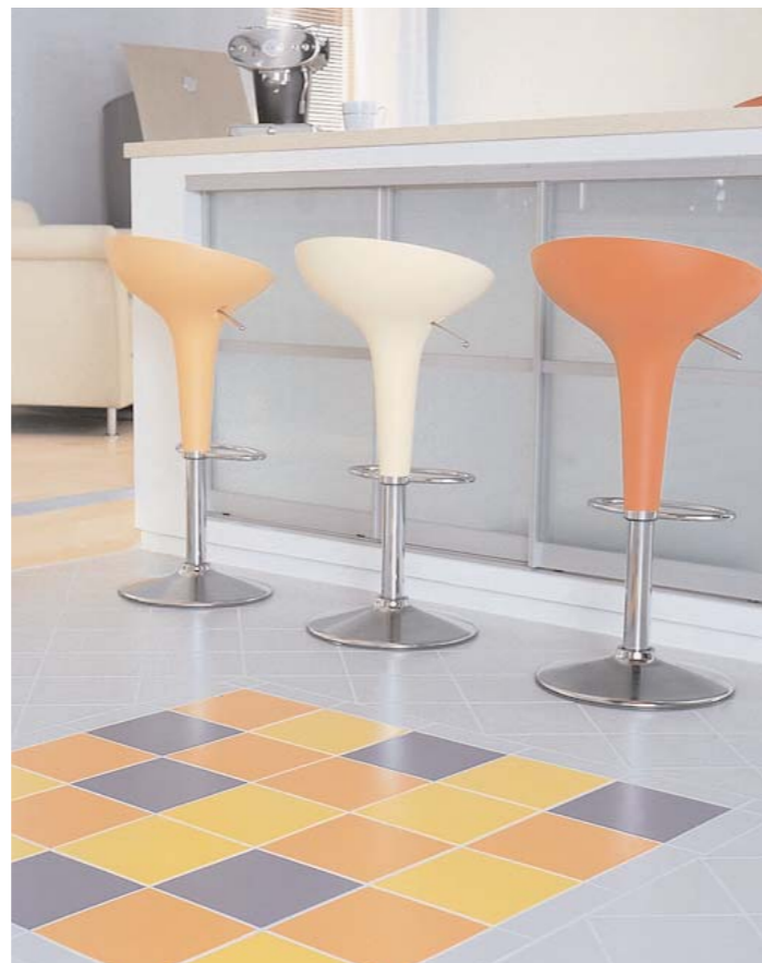
13 ... Sie müssen geeignete Passstücke zuschneiden. Die Fliesenverlegung für die Intarsie beginnt ...
