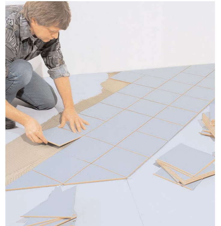
10 ... nämlich einmal diagonal. Ansonsten werden unter Umständen kompliziertere Zuschnitte nötig. Als Fliesenkleber verwenden Sie am besten Flexkleber oder Fließbettkleber für Bodenfliesen, ggf. mit Flexzusatz
