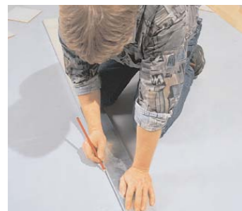
5 ... Intarsienbreite. Jetzt ziehen Sie zwischen den gemessenen Punkten eine Linie, die dann parallel zur ...
