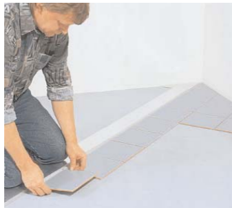
2 ... diagonal zu. Bevor Sie mit dem Kleben beginnen, werden die Fliesen erst einmal trocken ausgelegt
