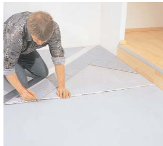
3 Für die quadratisch zu legende Intarsie messen Sie eine Strecke im 90-Grad-Winkel von der Wand weg
