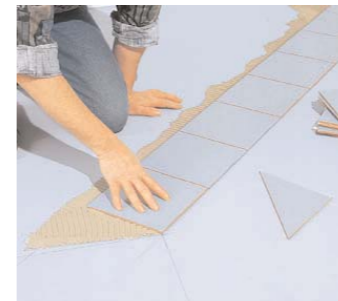
8 Die diagonal gelegten Fliesen sollten möglichst mit der Ecke an die quadratische Intarsie stoßen
