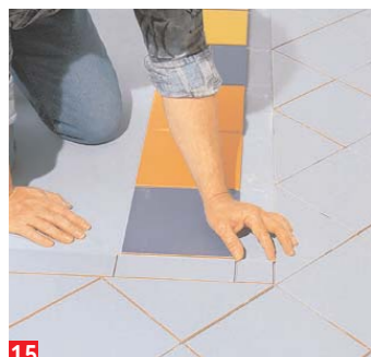
15 ... müssen Sie ebenso wie die Eckstücke entsprechend zuschneiden. Klappt dann alles bei der ...
