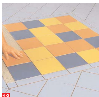
18 Die Farbzusammenstellung muss individuell bestimmt werden; auch eine einfarbige Intarsie ist möglich
