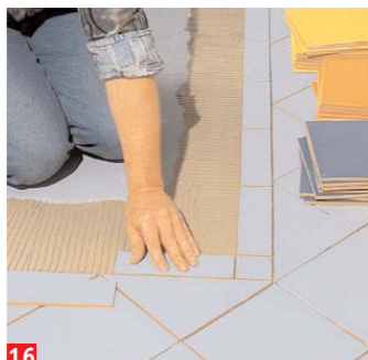
16 ... „Trockenübung“, rühren Sie den Fliesenkleber an und legen zunächst die schmalen Randstücke
