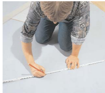
4 Diese markierte Entfernung übertragen Sie weiter unten im Raum entsprechend der gewünschten ...
