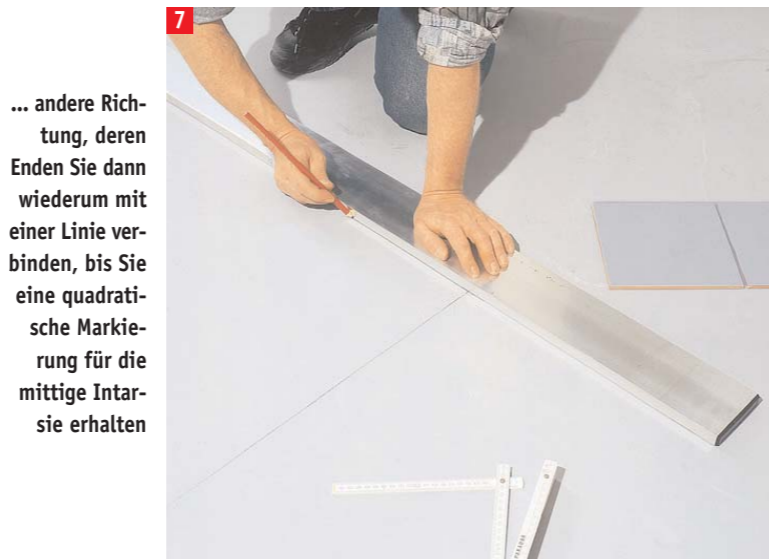
3 Für die quadratisch zu legende Intarsie messen Sie eine Strecke im 90-Grad-Winkel von der Wand weg
