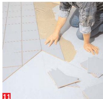
11 Auch die Länge der Intarsie sollte so bemessen sein, dass am Ende die diagonal verlegten Fliesen ...
