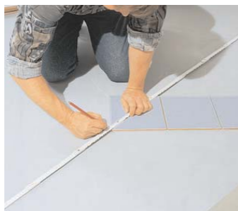
6 ... Wand verlaufen müsste. Von den beiden Eckpunkten markieren Sie nun im 90-Grad-Winkel Linien in die ...
