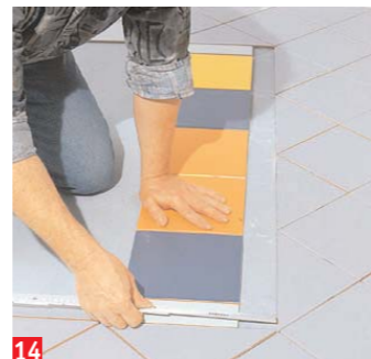
14 ... auch erst einmal trocken. Als Umrandung haben wir schmale Fliesenstücke vorgesehen. Diese ...
