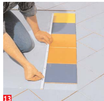
13 ... Sie müssen geeignete Passstücke zuschneiden. Die Fliesenverlegung für die Intarsie beginnt ...
