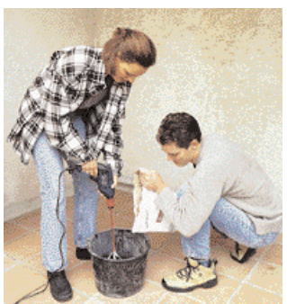
4 Preparate la malta adesiva con la quantità d'acqua necessaria per ottenere una massa pastosa.
