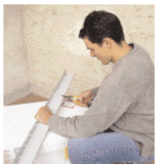
2 I profili del basamento possono essere tagliati facilmente con una cesoia per lamiera o una troncatrice.
