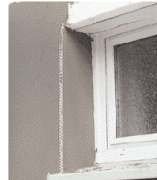
16 Rafforzate gli angoli esterni con profili d'angolo, inseriti e allineati nella malta adesiva
