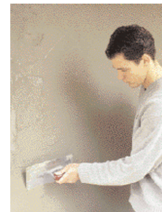
15 ... sovrapposizione di 10 cm. Infine stuccate di nuovo con malta adesiva
