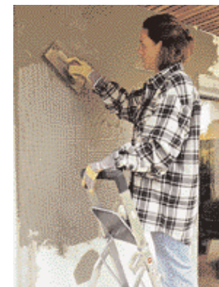
14 Stuccate i pannelli isolanti e comprimate l'armatura in tessuto con una
