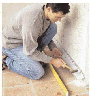
3 Fissate il profilo sopra l'intonaco del basamento, con i tasselli, perfettamente orizzontale nella parete della casa.
