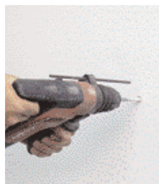
11 I pannelli vengono poi fissati con appositi tasselli. Per forare utilizzate ...
