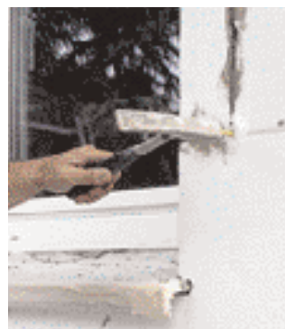
12 ... una battuta profonda. Conficcate in ogni incrocio dei giunti un tassello e due per ogni pannello
