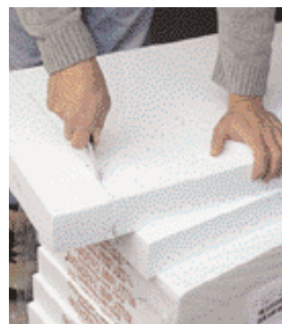
9 I pezzi di adattamento possono essere tagliati con una sega a mano o meglio ancora con un coltello tagliente
