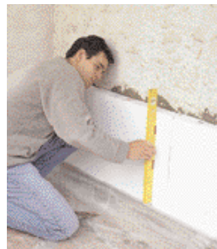
8 Deve essere posato dritto e allo stesso livello rispetto ai pannelli già applicati
