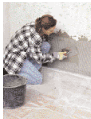
5 Stuccare con la malta adesiva il profilo e inserire delle strisce di tessuto larghe circa 60 cm
