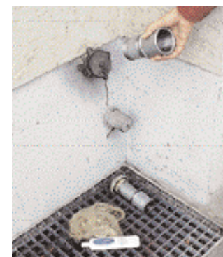
Svitare la parte superiore del bocchettone e collegare la prolunga.
