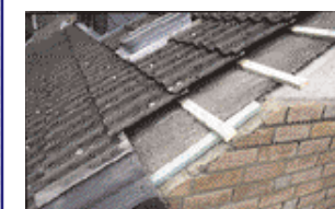
Bordo del tetto con bordura più larga. Aumentare la sporgenza del tetto.
