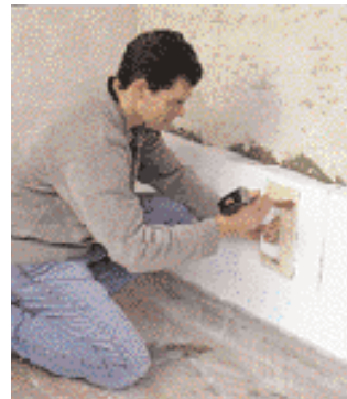
7 ... sul lato posteriore del pannello isolante. Inserite lo spigolo nel profilo. Premete con forza il pannello
