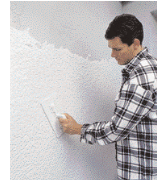
18 Livellate l'intonaco e strutturate con movimenti circolari
