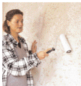
1 Una mano preliminare con un fondo universale stabilizza l'intonaco sabbioso e garantisce fondi che assorbono in modo uniforme.
