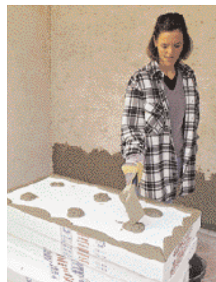
6 Dopo che la malta ha fatto presa, applicatela su tutto il perimetro e in sei punti a «mucchietto» ...
