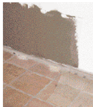
10 Quando una parte di parete è coibentata, stuccate con la malta adesiva il tessuto applicato all'inizio
