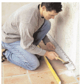
3 Befestigen Sie das Profil über dem Sockelputz mit Nageldübeln genau waagrecht in der Hauswand
