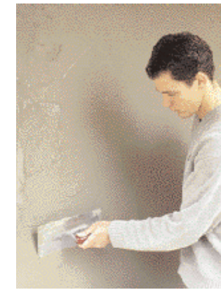
15 ... Überlappung von 10 cm eindrücken. Anschliessend nochmal mit Klebemörtel überspachteln
