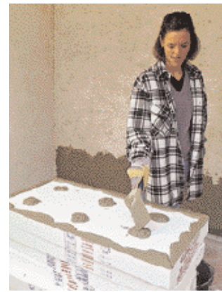
6 Hat der Mörtel angezogen, geben Sie den Kleber umlaufend und an sechs Punkten batzenförmig auf ...
