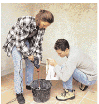
4 Rühren Sie nun den Klebemörtel mit Wasser im angegebenen Verhältnis zu einer pastösen Masse an
