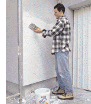
17 Nach dem Voranstrich mit weisser Grundierfarbe ziehen Sie den Reibputz mit der Kelle auf
