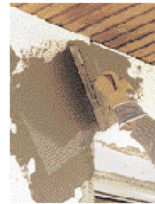
13 An allen Fensterecken bettet man zunächst Armierungsstreifen diagonal in Klebemörtel ein
