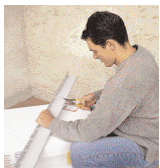
2 Die Sockelprofile lassen sich mit der Bleischere oder einem Trennschleifer leicht ablängen
