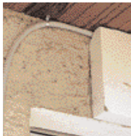
Das Leerrohr verläuft hinter der abgeschrägten Plattenkante
