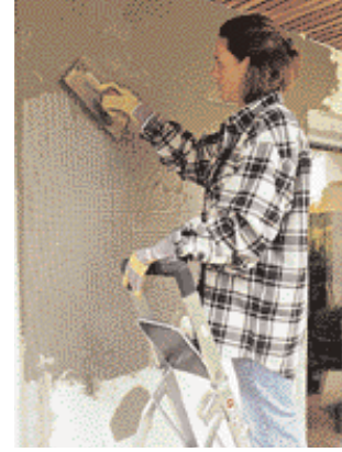
14 Dann die Dämmplatten verspachteln und die Gewebearmierung bahnenweise mit einer ...
