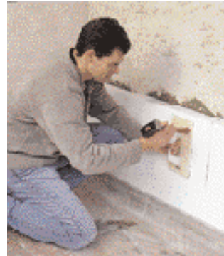
7 ... die Rückseite der Dämmplatte. Die untere Kante in das Profil einsetzen. Die Platte fest andrücken
