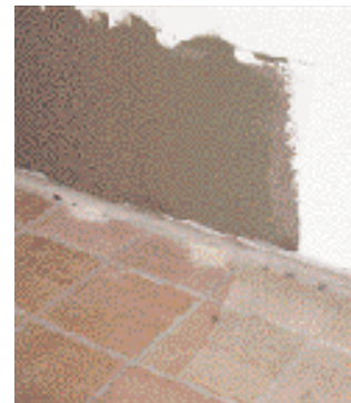
10 Ist ein Wandabschnitt gedämmt, verspachtelt man das zu Beginn eingelegte Gewebe mit Klebemörtel
