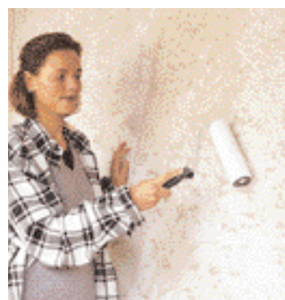
1 Ein Vorstrich mit Universalgrund festigt sandenden Putz und sorgt für einheitlich saugende Untergründe
