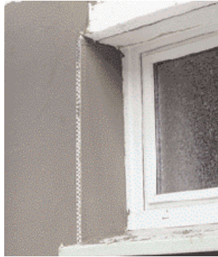
16 Aussenecken verstärken Sie mit Eckprofilen, die Sie in Klebemörtel einbetten und ausrichten
