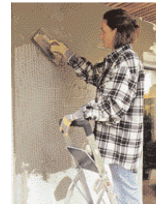
14 Dann die Dämmplatten verspachteln und die Gewebeamierung bahnenweise mit einer ...
