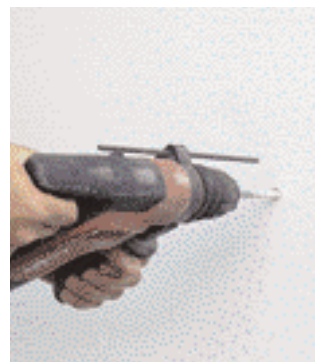
11 Die Platten werden zusätzlich mit Tellerdübeln befestigt. Benutzen Sie beim Bohren einen ...
