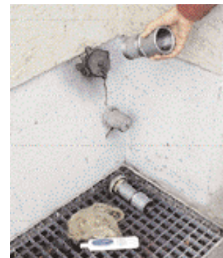
Den oberen Teil des Stutzens abschrauben und Verlängerungen einsetzen
