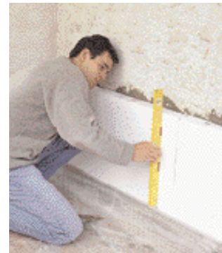
8 Sie muss gerade und oberflächenbündig zu den zuvor verlegten Dämmplatten verklebt werden
