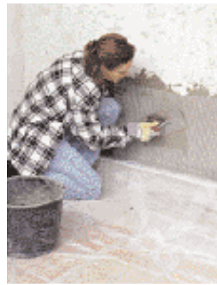
5 Das Profil mit Klebemörtel verspachteln und einen 60 cm breiten Gewebestreifen einarbeiten
