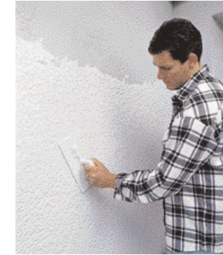
18 Den aufgetragenen Putz in Kornstärke abziehen und mit kreisenden Bewegungen strukturieren
