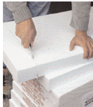
9 Passstücke lassen sich mit einer Handsäge oder besser noch mit einem scharfen Messer zuschneiden
