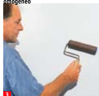
3 ... rullo di gommaspugna in modo da non lasciare bolle. La colla d'amido in eccesso va eliminata con una spugna bagnata...
