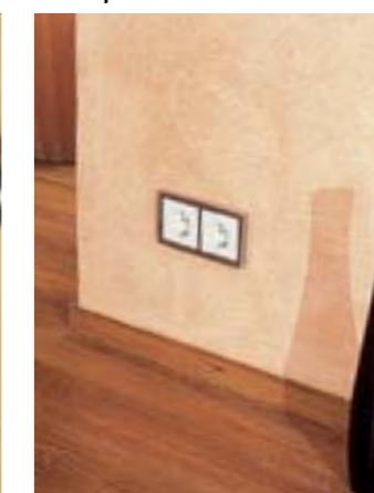
Contrasti della superficie vivacemente accentuati dalla vernice distesa: a sinistra quella modellata con la cazzuola, a destra il muro strutturato con il pennello
