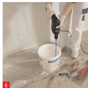
6 Mischiare con cura il fondo sabbioso con un miscelatore.
