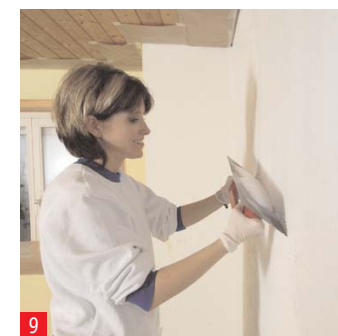
9 Non appena il fondo sabbioso si è asciugato, con una cazzuola levigata di acciaio, si può applicare l'intonaco.
