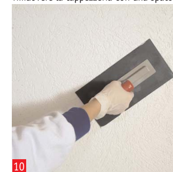
10 Ora, l'intonaco applicato va distribuito. A seconda della struttura desiderata possono essere utilizzati diversi dischi a frizione.
