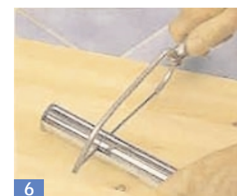
6 I raccordi di tubo arrugginiti vengono sostituiti. Tagliateli della misura giusta con la sega per il metallo e poi sbavateli.
