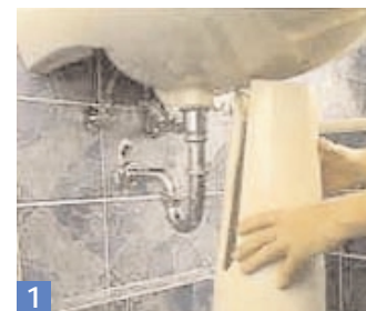
1 Wird der Siphon von einer Standardsäule verdeckt, müssen Sie diese entfernen. Dafür das Becken losschrauben und leicht anheben.
