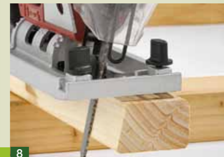
8 Tagliare in obliquo gli elementi longitudinali e preforarli
