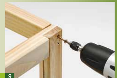
9 Avvitare i telai laterali con i sostegni longitudinali
