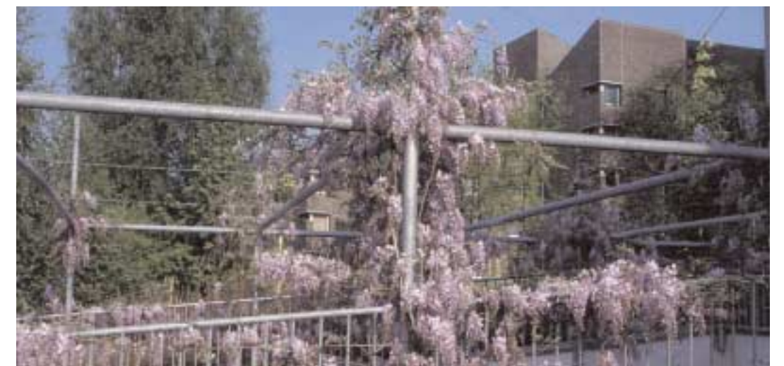
Stahlrohrgerüst mit Spanndrähten und Blauregen
