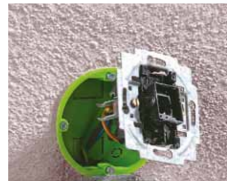
3 Di regola c'è una graffa che trattiene il telaio, togliere o svitare anche quella
