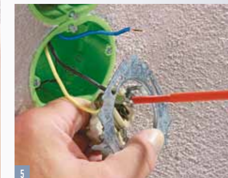
5 I vecchi interruttori sono solitamente montati con serrafili a vite, in tal caso svitare con un cacciavite
