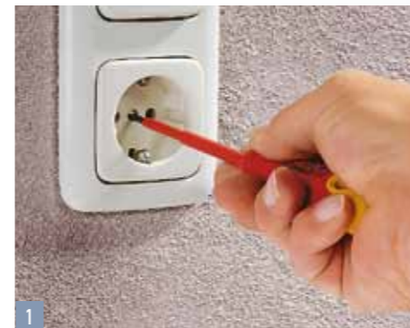
1 Dopo aver controllato l'assenza di corrente (vedi riquadro a destra) svitare o togliere il frontalino
