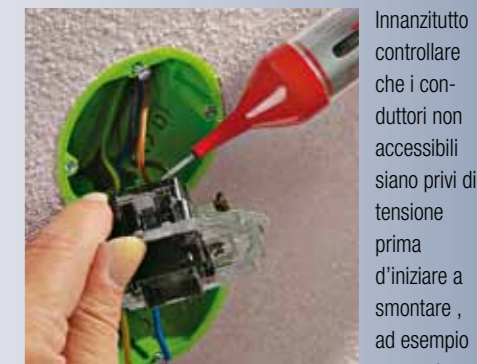
6 Innanzitutto controllare che i conduttori non accessibili siano privi di tensione prima d'iniziare a smontare, ad esempio con un tester del tipo Dupsol
