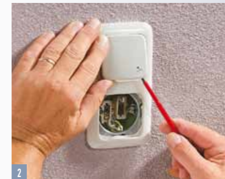
2 Sollevare con cautela la copertura del pulsante, eventualmente aiutandosi con un cacciavite
