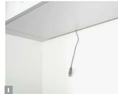
1 Posate il cavo dietro l'armadio, facendolo uscire nel punto in cui successivamente verrà fissata la lampada.
