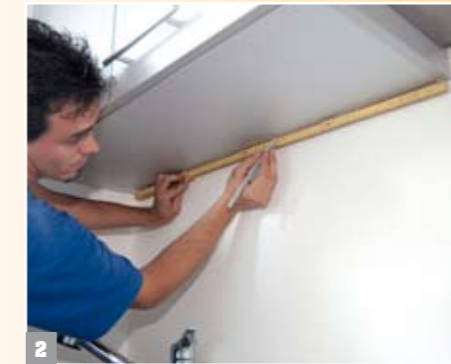
2 Con metro e matita individuate il centro della lampada.
