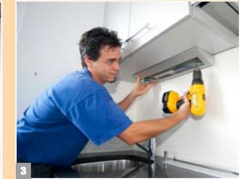
3 Tenete la lampada sollevata e marcate i punti per i fori che successivamente andranno sgrassati con il trapano.
