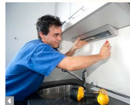
4 Ora è possibile fissare la lampada con le viti fornite.
