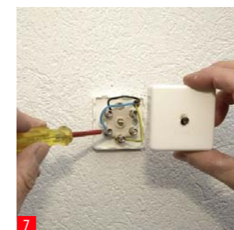
7 A seconda del tipo d'interruttore, i fili del quadro elettrico della casa vanno fissati con il rilevatore.
