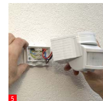
5 Allacciare il rilevatore di movimento alla rete elettrica.
