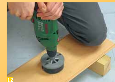
12 Per fare i fori per i faretti a soffitto, vi occorre una sega da traforo. Assicuratevi che il rivestimento sia stabile!
