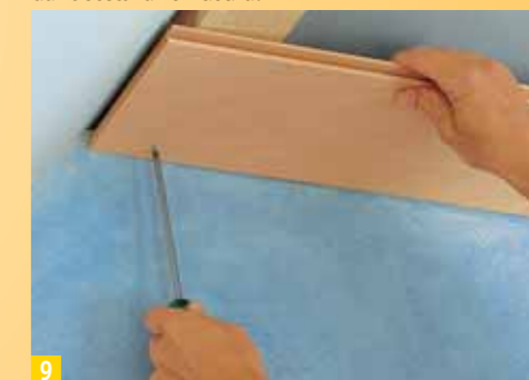
9 Il diametro di foratura deve essere circa un millimetro in meno di quello delle viti! Una volta fatti i fori, fissate la perlina con le viti
