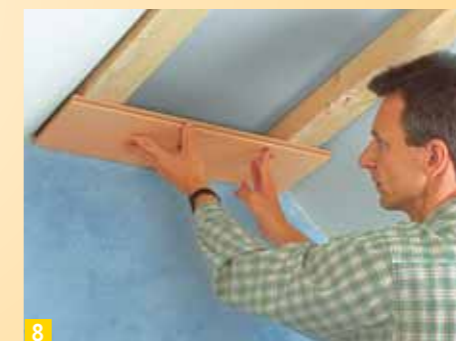
8 Prima di forare, reggete la perlina e disegnatevi sopra i punti di foratura centrati.
