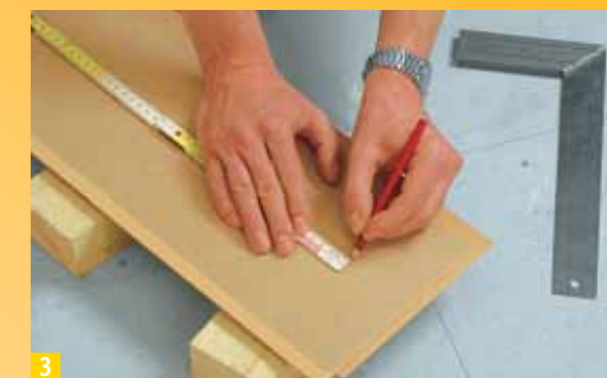
3 Successivamente riportate sulla prima perlina la distanza misurata. Fare attenzione che tra le perline e la falda del tetto resti una ...
