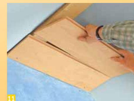
11 Una volta tagliato l'elemento successivo è sufficiente incastrarlo in quello precedente e fissarlo con la graffatrice.
