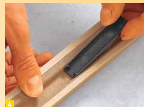
4 Sul lato interno dei listelli, negli spazi corrispondenti, collocate le parti che andranno a chiudersi con i clip quando applicherete le perline
