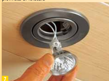
7 Infine verranno montate le lampadine alogene. A questo punto verificate se tutti i collegamenti funzionano e se le lampadine si accendono.
