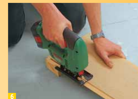
6 Con la prima perlina bisogna anche tagliare la linguetta, perché altrimenti la linguetta e la fuga di dilatazione non possono essere ricoperti dai listelli di chiusura.
