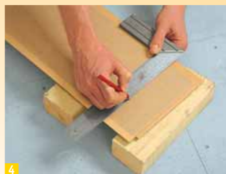
4 ... fuga di dilatazione circa 10 mm, poiché la capriata lavora. Una volta prese le misure corrispondenti, disegnate ...
