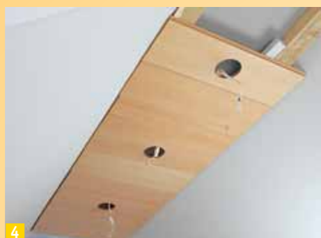
4 ... fate passare i fili attraverso l'apertura. Ora, a seconda della lunghezza dei cavi, potete applicare due o tre perline prima di utilizzarne un'altra provvista di foratura
