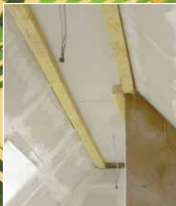
Prima di procedere al rivestimento delle falde inclinate sono state avvitate le travi per il montaggio delle perline.
