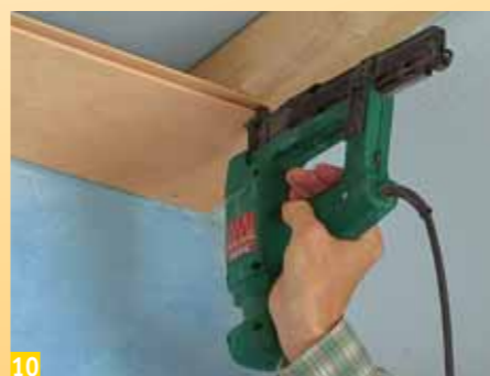
10 Tutte le altre perline saranno fissate solo con una graffatrice, sempre sul lato della scanalatura. A tale scopo utilizzare graffette della lunghezza di almeno 12 mm.
