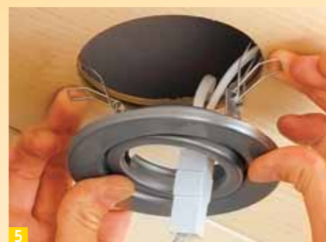
5 Una linea di alimentazione con il trasformatore è sufficiente per tre lampadine. Il montaggio dei faretto è semplice: dovete fissarli all'apertura della perlina con due mollette ciascuno su entrambe i lati.
