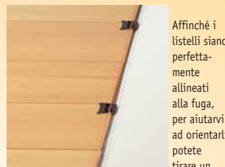
3 Affinché i listelli siano perfettamente allineati alla fuga, per aiutarvi ad orientarli potete tirare un filo lungo la falda del soffitto
