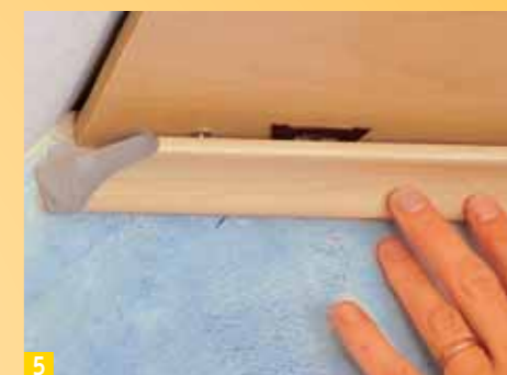
5 La distanza tra i clip dev'essere scelta in modo che ogni listello possa essere fissato con almeno due clip, o ancora meglio con tre.
