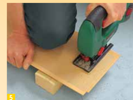
5 ... lo spigolo di taglio. Successivamente adagiate la perlina su due supporti di rivestimento e tagliatela a misura con una sega a gattuccio.
