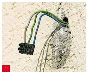
1 Nel nostro caso è stata prima smontata la lampada difettosa
