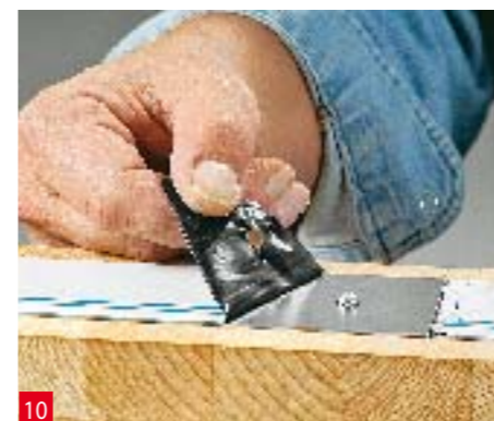
10 Infine togliete la pellicola di protezione dalla lamina e levigatela con uno straccio asciutto.
