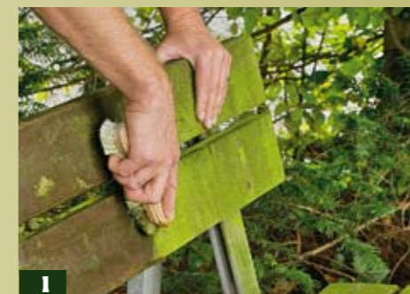
1 Prima della verniciatura, sporco e alghe devono sparire – si può procedere con della soda o con speciali detergenti e spazzola.
