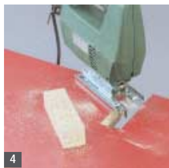
4 ... del vostro seghetto alternativo. Ritagliate lo spazio. In seguito il resto del foro sarà coperto dall'elemento di supporto.
