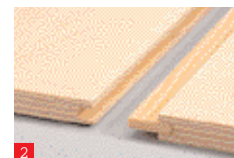
2 ... in modo continuo, quelle lunghe in modo intermittente. Congiungete i pannelli con linguette da listelli di 5 x 20 mm.
