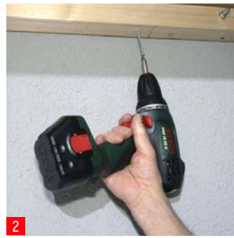
2 Fissare il piano di lavoro alla lista di legno dal di sotto con delle viti lunghe.
