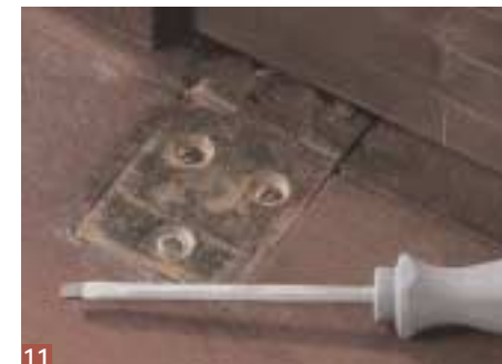
11 Avvitare le viti nel mastice ancora molle. Attenzione: occorre forza!
