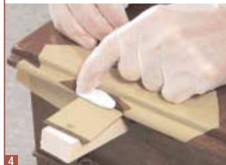
4 ... finché il mastice risultante è diventato completamente bianco. A questo punto avete 5 minuti di tempo per applicare la resina profondamente, in modo ben saldo e fino negli angoli dell'area danneggiata.
