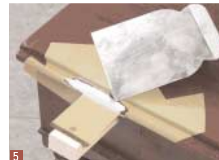
5 Con una spatola, che dovrebbe essere più larga del punto danneggiato, ripassate il profilo per adattare la superficie alla forma di quest'area.
