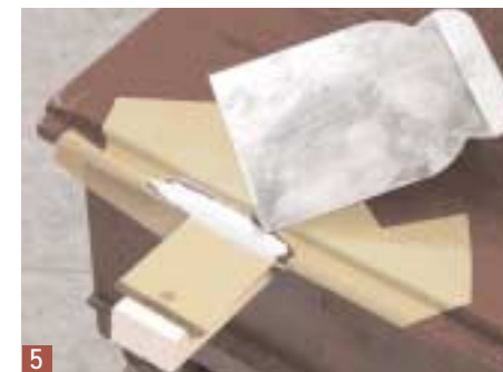
5 Suivez le profil avec une spatule qui devrait être plus large que l'endroit endommagé, afin d'adapter la surface à la forme de l'endroit à réparer.
