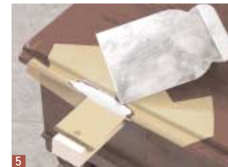
5 Mit einem Spachtel, der breiter sein sollte als die Schadstelle, fahren Sie das Profil nach, um die Oberfläche der Form dieser Stelle anzupassen
