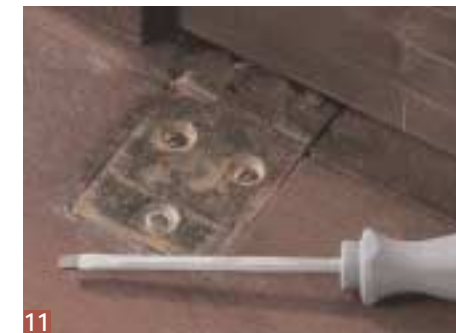
11 Dann sollten Sie die Schrauben in die noch weiche Knetmasse drehen. Achtung: Dazu ist einiges an Kraft erforderlich!
