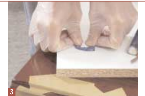
3 Latex-Handschuhe überstreifen und eine Scheibe Zwei-Komponenten-Reparaturknete abschneiden. Die zweifarbige Masse kneten, ...
