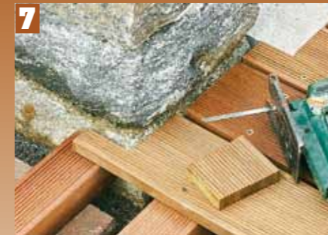
7 Tout d'abord dessiner les découpes le long des murs, des portes et des escaliers, puis les découper à l'aide d'une scie sauteuse.
