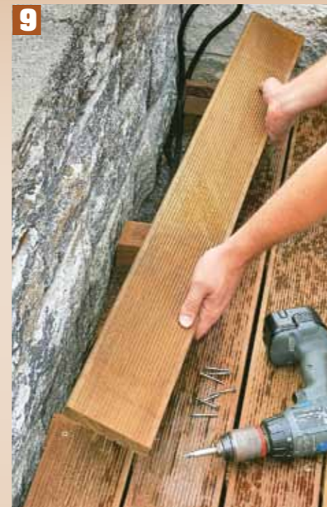
9 Faire passer le câble électrique pour l'installation de la lumière à un endroit adéquat avant la pose des planches de fermeture.
