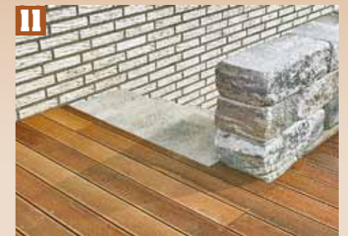
11 Voici comme cela doit être: l'assemblage avec l'escalier en pierre est posé à franc-bord.
