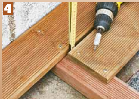
4 Visser les planches en respectant un espace d'aération de 3 à 5 mm. Le mètre pliant sert à maintenir un écartement régulier.
