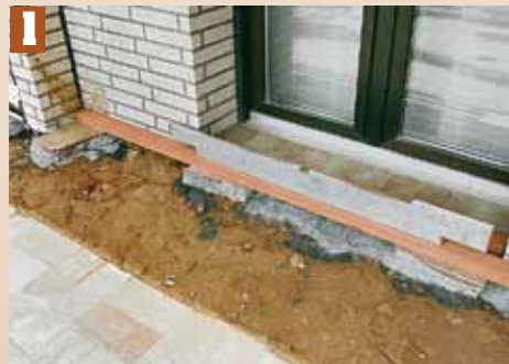
1 La porte de la terrasse est la base de départ pour la hauteur du revêtement en bois. Poser la première planche et la soutenir en conséquence par-dessous.
