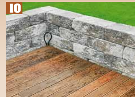
10 Un espacement de 5 à 10 mm doit rester entre le mur et les planches de fermeture, afin que le bois puisse normalement travailler.
