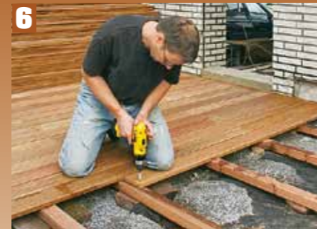
6 Avant de visser, il faut absolument percer le bois.
