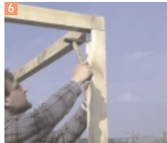
6 Lorsqu'une poutre traversante repose sur des poteaux d'angle, des plaques de fixation ne sont pas nécessaires.
