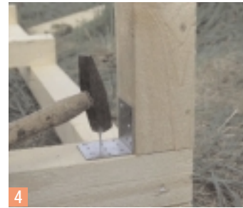
4 La construction continue par les poteaux d'angle. Les plaques d'angle permettent une fixation simple. Elles se fixent avec des clous ou des vis. Il est très important que la construction soit surélevée et en aucun cas en contact avec le sol, faute de quoi les poutres pourrissent très rapidement.
