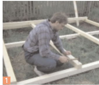
1 Les carrelots pour le plancher seront fixés aux poutres posées transversalement sur les fondations. Ils ne doivent pas être trop espacés.
