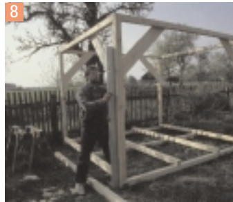
8 Avant de fixer définitivement tous les éléments de la structure, la verticalité des poteaux d'angle doit être contrôlée une dernière fois et rectifiée si nécessaire.
