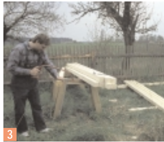
3 De simples carrelots (8 x 8 ou 10 x 10) permettent de réaliser une construction solide. Ils seront d'abord sciés aux dimensions voulues. En l'absence de courant électrique, ils seront sciés à la scie de pionnier; une tronçonneuse facilite le travail.
