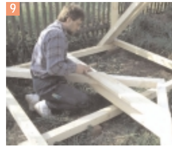
9 La charpente pour le toit en pente sera taillée sur le sol aux dimensions voulues et après seulement montée. Deux planches servent à tenir les chevrons assemblés.
