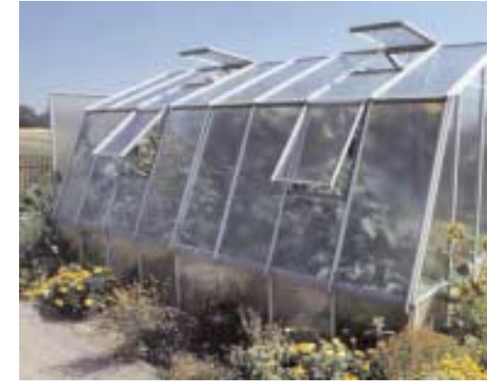
Le type classique de serre possède un toit en bâtière et une couverture en verre. Il est important qu'elle soit équipée en suffisance d'aérations.
