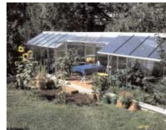
Deux kits permettent de construire une longue serre mitoyenne.
