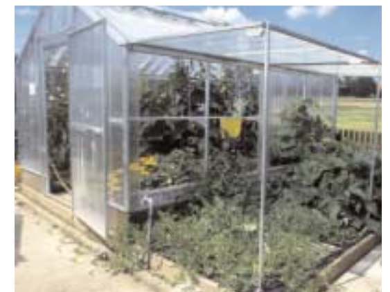
Une paroi latérale amovible présente des avantages; des profils d'angle en aluminium permettent cette transformation sur des serres conventionnelles.
