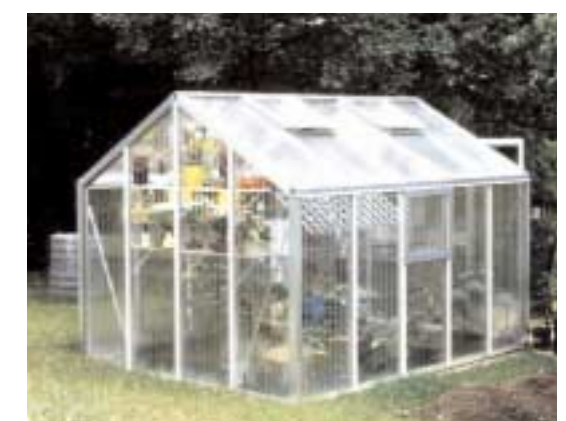
La majorité des divers types de serre est équipée de plaques à doubles parois alvéolaires en verre acrylique.
