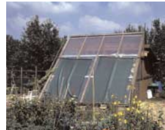
Une serre à appentis peut-être adossée à une cabane de jardin par exemple. Des plaques à doubles parois alvéolaires en verre acrylique se prêtent bien à sa fabrication.
