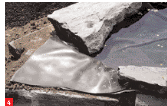
4 Les bords du film dépassant le mur doivent être coupés le long de la couche supérieure de pierre. La dernière couche recouvre le film.
