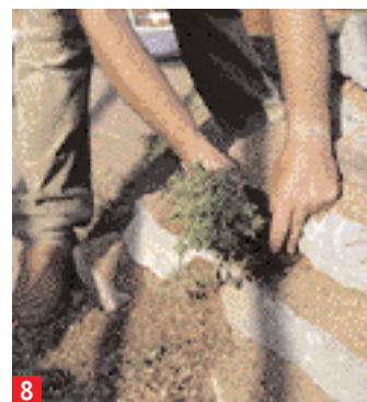
8 Les espaces entre les pierres du mur suffisent à des plantes peu exigeantes.
