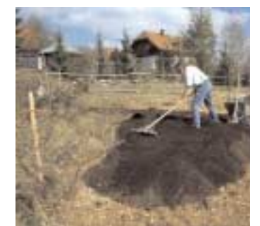
Répartition de bonne terre végétale sur un mauvais sol.
