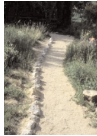
I viali ricoperti con ghiaia rotonda hanno il vantaggio di drenare rapidamente l'acqua piovana.
