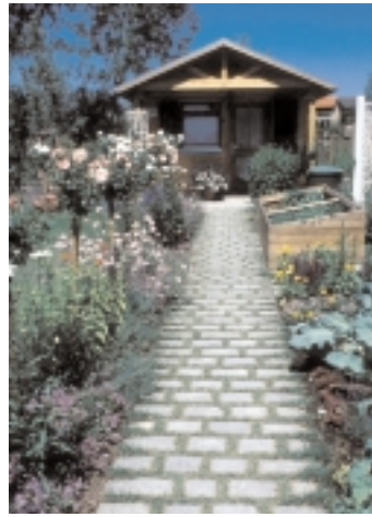
Le pavimentazioni di viali che vengono costruite con grandi fughe consentono la semina di erba.
