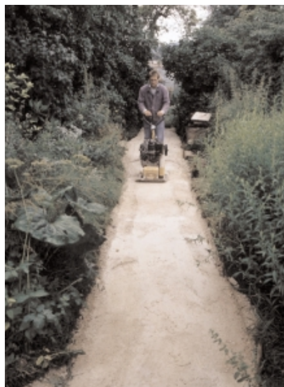
I viali principali dovrebbero essere ben ancorati. Una pavimentazione con pietre piccole necessita di un sottofondo in ghiaia resistente al peso.
