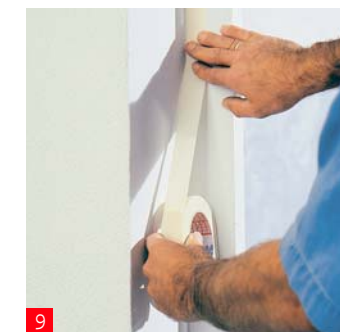
9 ... andrücken, gegebenenfalls stärker gekrepptes Band verwenden, das sich der Struktur besser anpasst
