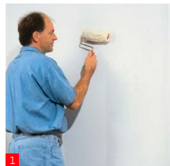
1 Den Kleister für die Raufaser gleichmässig bahnenbreit auftragen. An den Nähten sollte beim Tapezieren ...
