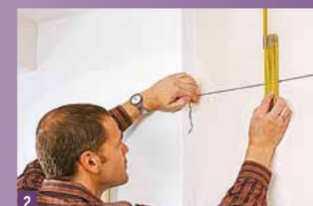
2 Puis tirer une ficelle directrice alignée au moyen d'un mètre pliant et d'un niveau à bulle
