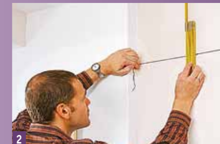
2 Nun wird eine Richtschnur gezogen und mit Zollstock und Wasserwaage ausgerichtet
