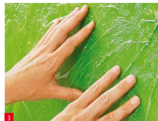
Die Folie wird auf die Wand gelegt. Mit dem Druck der Hände wird der Effekt variiert
