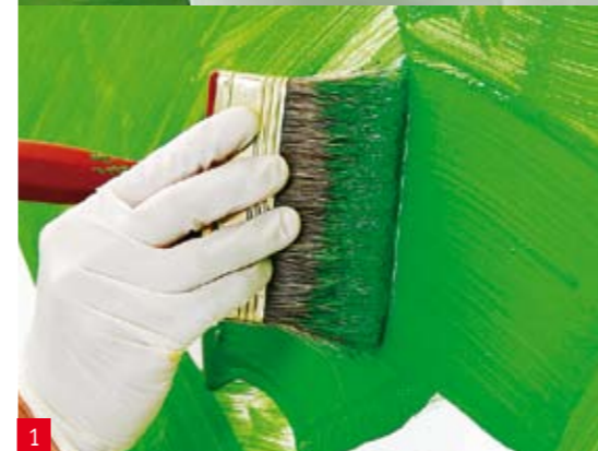
Die Farbe wird kreuz und quer mit dem Flächenstreicher auf ein Stück Wand aufgetragen
