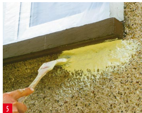
5 Come per l'interno della casa, prima imbiancate angoli e spigoli con un pennello piatto adeguato
