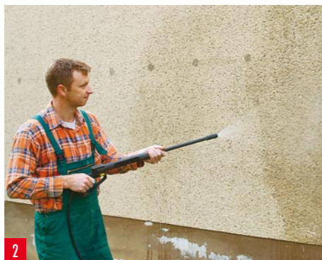
2 Il fondo deve essere pulito. La cosa migliore è pulire la facciata con un apparecchio ad alta pressione
