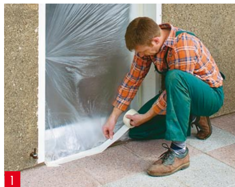
1 Finestre (davanzali), eventualmente l'intero stipite, così come le porte dei balconi vanno protette con una pellicola e del nastro adesivo di carta
