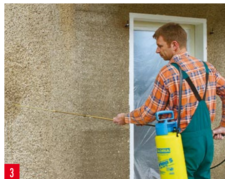
3 La mano di fondo va passata con una pennelles-oppure con un nebulizzatore da giardiniere
