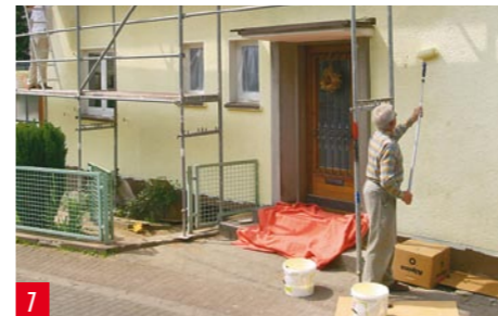
7 Eventualmente per raggiungere alcune zone potete usare un manico telescopico per il rullo. Gli stipiti...
