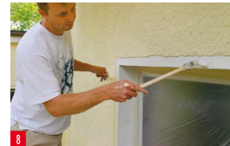
8 ... da colorare li potete passare con un pennello. Passare sempre una mano di fondo e una finale!
