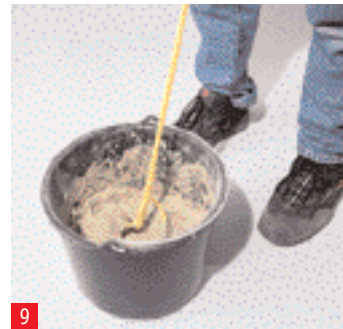
9 adesso mischiare un collante per piastrelle – con il collante Flext non potete quasi sbagliare nulla
