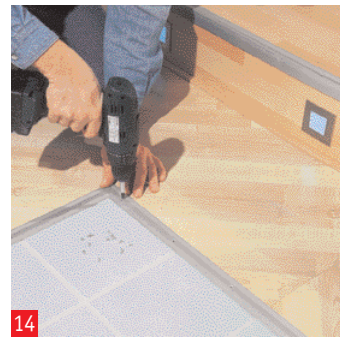
le liste vengono montate con delle viti come quelle sui profili degli spigoli della scala
