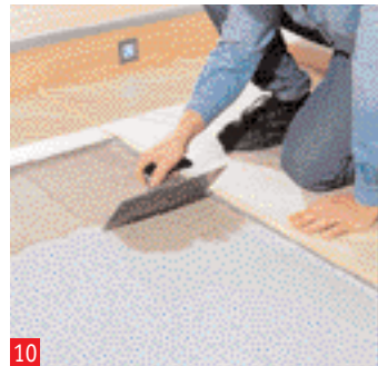
10 riportare il collante sulla soletta di cemento liberata in sezioni con una spatola dentata
