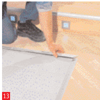
dopo che la malta delle fughe si e' essiccata si possono montare i profili
