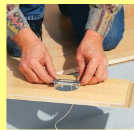
Dopodiché inserire gli spot ed incollare bene l'elemento del parquet là dove i gradini si congiungono
