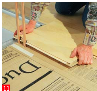
11 L'elemento del parquet non deve essere troppo vicino ai tubi altrimenti ne viene trasmesso il rumore
