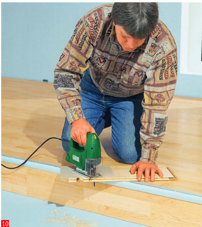
10 ... la posizione dei tubi al punto corrispondente sull'elemento del parquet. Dopodiché tagliate l'elemento – nel migliore dei casi con un gattuccio elettrico – come marcato.
