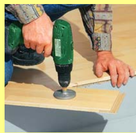
Con una lama per traforo fare i buchi per il montaggio delle lampade alogene
