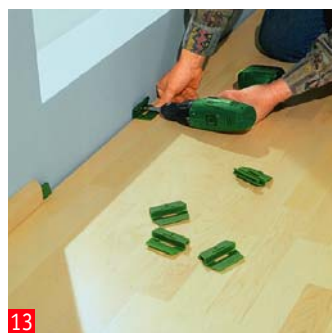
13 Per il montaggio dello zoccolo vi sono dei clip che vanno avvitati prima alla parete
